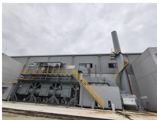
1号厂房印刷、复合废气处理设施RTO+20m排气筒
